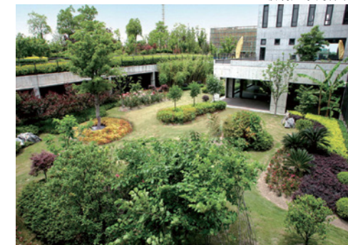
绿坡下的半地下车库
