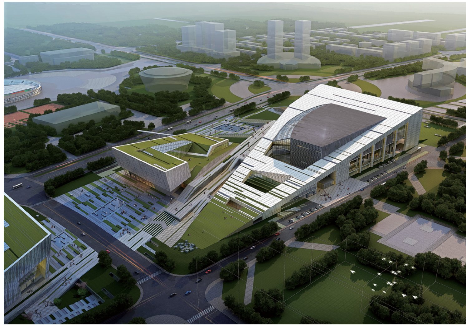
项目名称：长治市六大惠民公共设施 设计时间：2013年 项目面积：15万㎡
