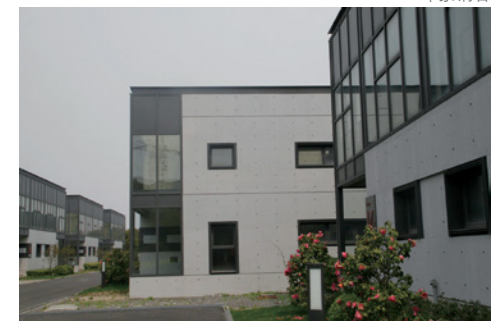
素混凝土立面
